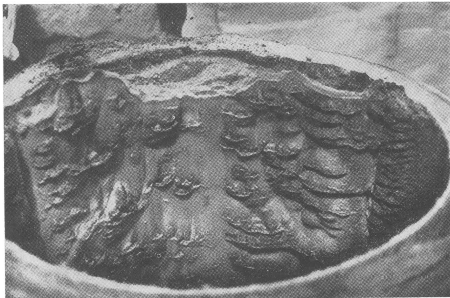
Рис. 59. Кора сфалерита в трубопроводе
