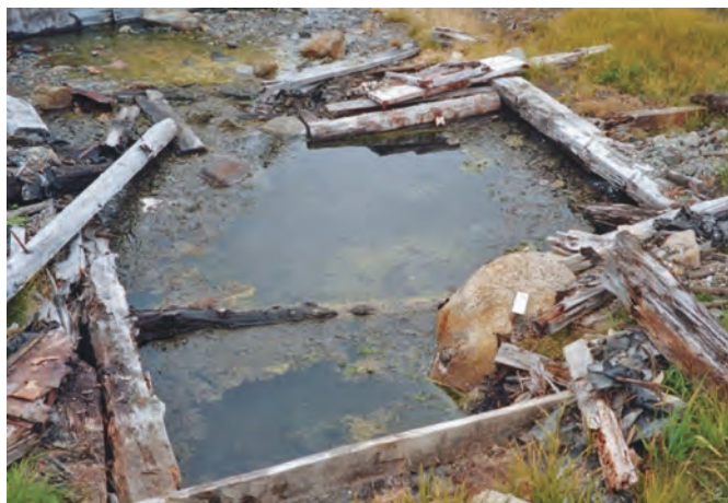
Рис. 3.1.4.3. Кивакские источники, полуразрушенный колодец, каптирующий источник 4а. Фото авторов
