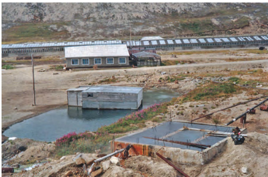
Рис. 3.2.5.3. Кукуньские источники. На переднем плане в центре – каптаж грифона № 1, от него идет теплопровод, далее – термальный бассейн с дощатой крытой купальней (грифон № 2), на заднем плане – гостиница и тепличное хозяйство. Фото авторов
