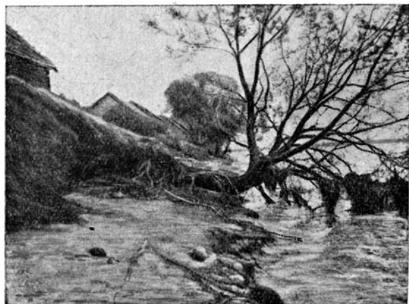
Рис. 14. Подмыв угрожает домам д. Городище на Волжском водохранилище
